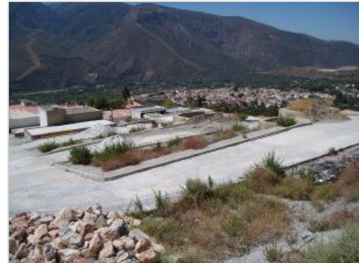
ESPACIO. Obras de ampliación en el actual camposanto. /R. V.
