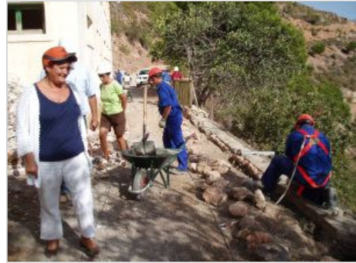
OBRAS. La alcaldesa de Órgiva durante la visita a las obras. /R. V.
