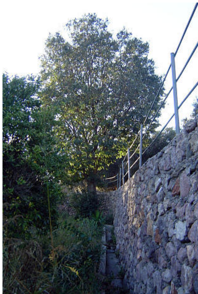
Imagen de los pilares de piedra y el árbol centenario. La Opinión
